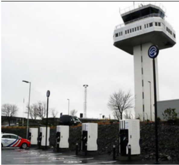
Figur 5 (venstre): Deltaladarar med tre uttak og effektdeling på drosjedepot ved Bergen lufthavn Foto:Thomas J Potter. Figur 6 (høgre): 350 kW Ladar frå ABB.
