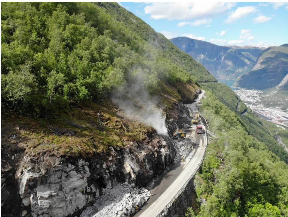
Figur 16 Arbeidet med skredsikring ved fv. 53 Ljoteli 29
