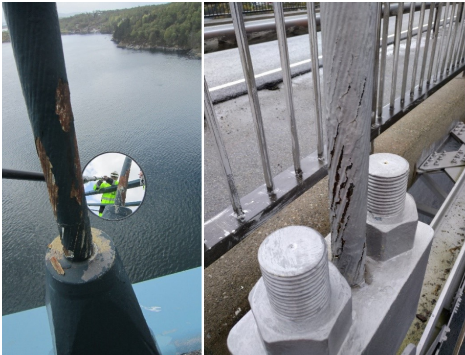
Figur 24 Ettersyn av Bømlobraua fv. 542
