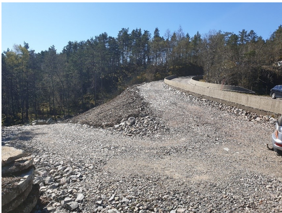
Figur 15 Midlertidig lagring av overskotsmassar langs fv. 570
