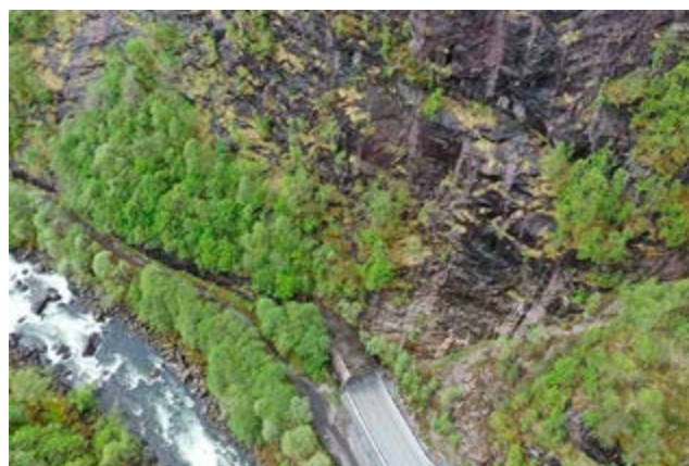
STÅLPORTAL: Tunnelmunninga ved Liarostunnelen i Samnanger kommune skal skredsikrast med den nye stålportalen i 2022, i eit prøveprosjekt hjå Vestland fylkeskommune. Foto: Vestland fylkeskommune
