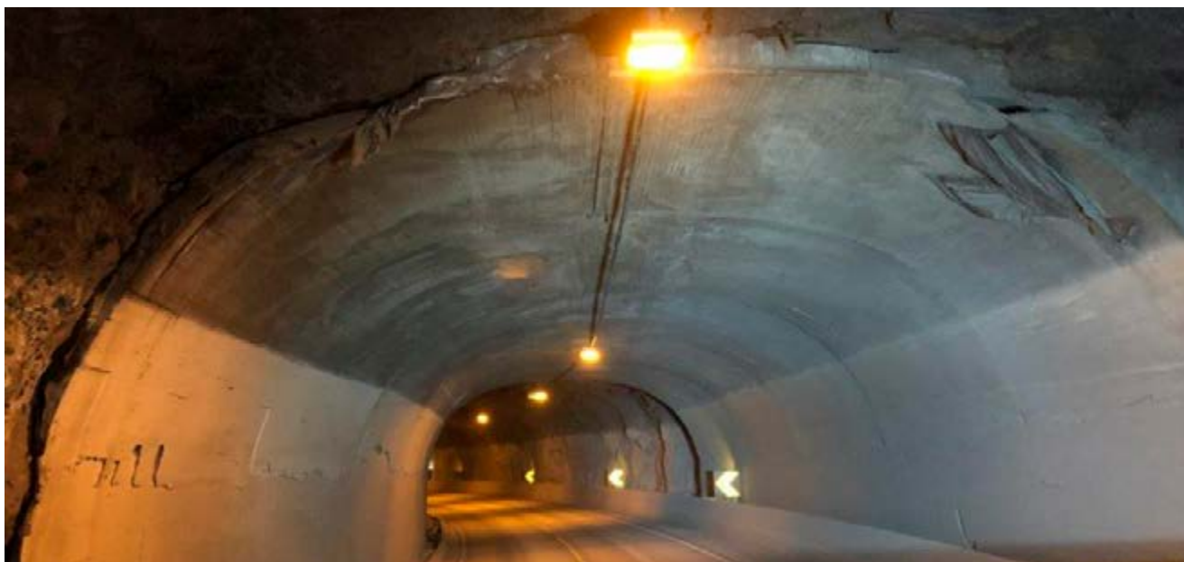
Steiggjattunnelen er ein tunnel på fylkesveg 53 i Vestland.
